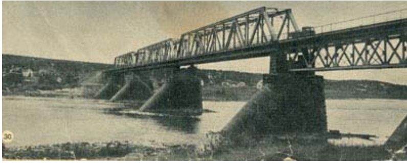
Rovaniemeltä Kemijoen yli johtava silta ennen räjäytystä. Kuva: Signal lokakuu 1942.
